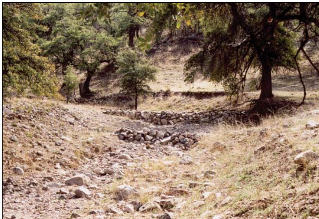
Figura 1. Cortinas hechas de piedra para retener sedimentos e incrementar humedad en Milpillas, Sonora, construidas en la primavera 2003.
