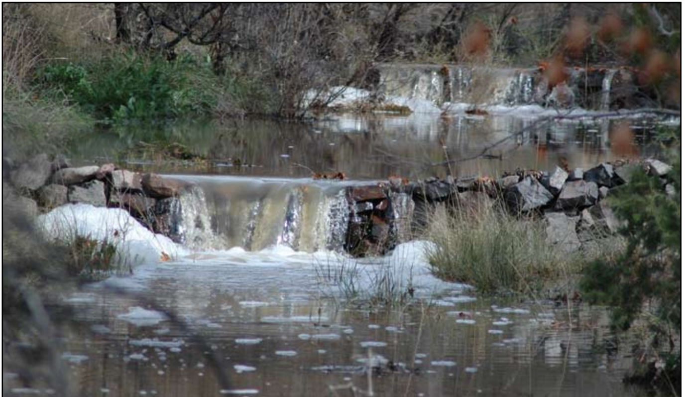
Trincheras después de la corriente.
