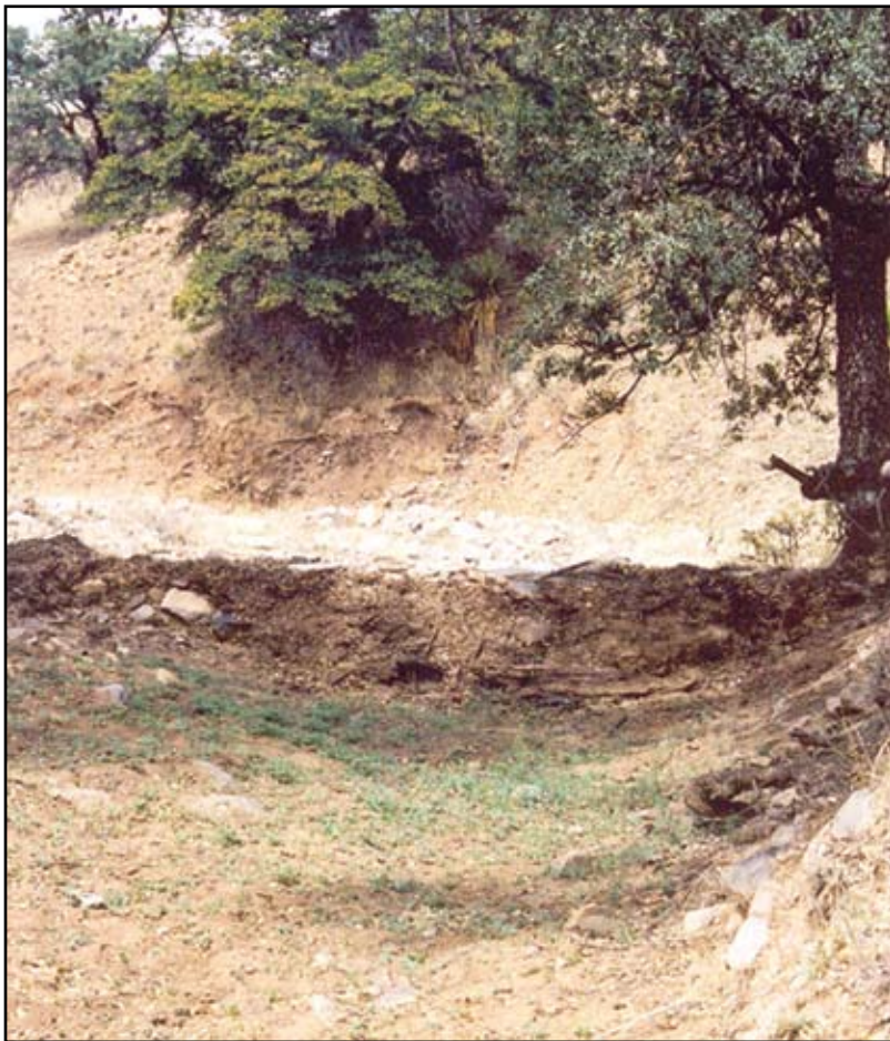
Figura 2. Misma cortina, después de las lluvias de verano 2003 muestra resultados positivos en la retención de suelo e incremento de humedad. Note las primeras plántulas brotando. Foto Murrieta y Emanuel 2003.
