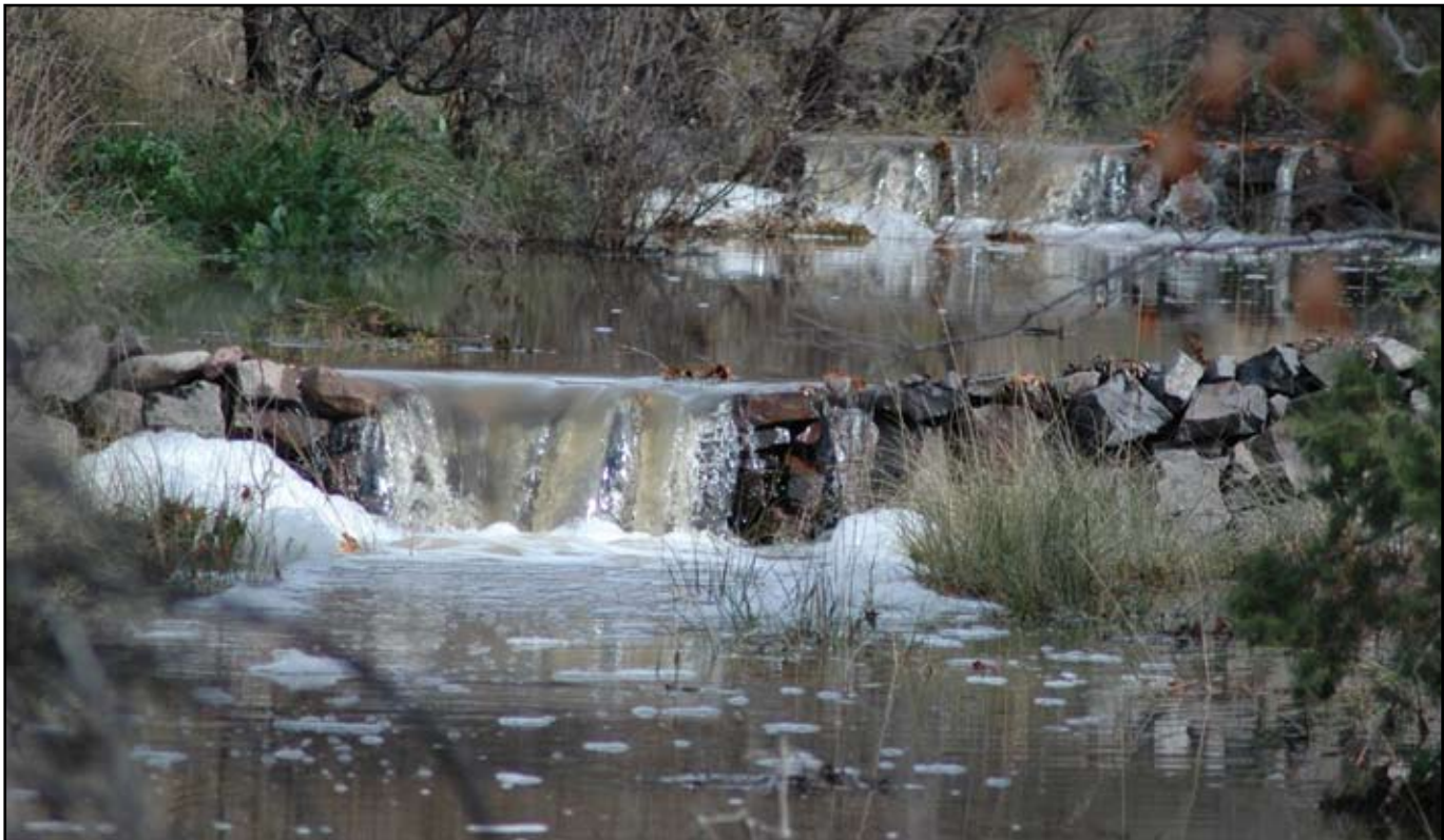
Trincheras después de la corriente.
