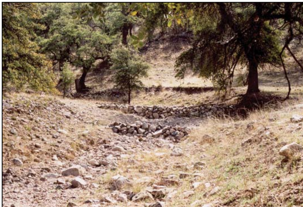
Figura 1. Cortinas hechas de piedra para retener sedimentos e incrementar humedad en Milpillás, Sonora, construidas en la primavera 2003.
